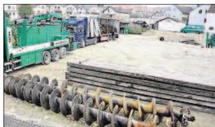
Die Schneckenbohrer liegen bereit: Diese werden zwölf Meter tief in den Boden getrieben. Fotos: Knopp
